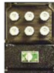
AUTOMATISCHE ZEKERING
